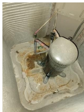
Interior Unidad Condensadora (Antes del Mantenimiento)
