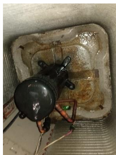
Interior Unidad Condensadora (Después del Mantenimiento)
