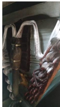
Serpentín Unidad Evaporadora (Antes del Mantenimiento)
