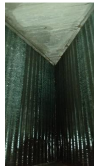
Serpentín Unidad Evaporadora (Después del Mantenimiento)
